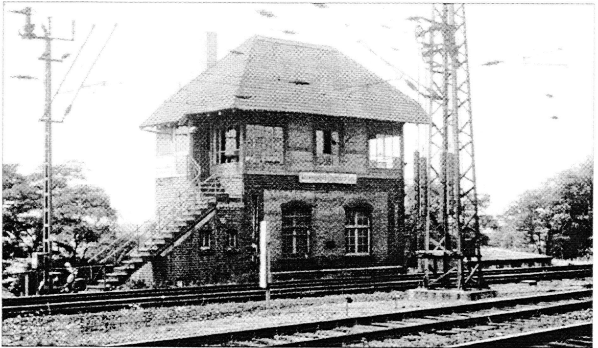
Oben die alte Abzweigstelle Oberbaurat Sigle
