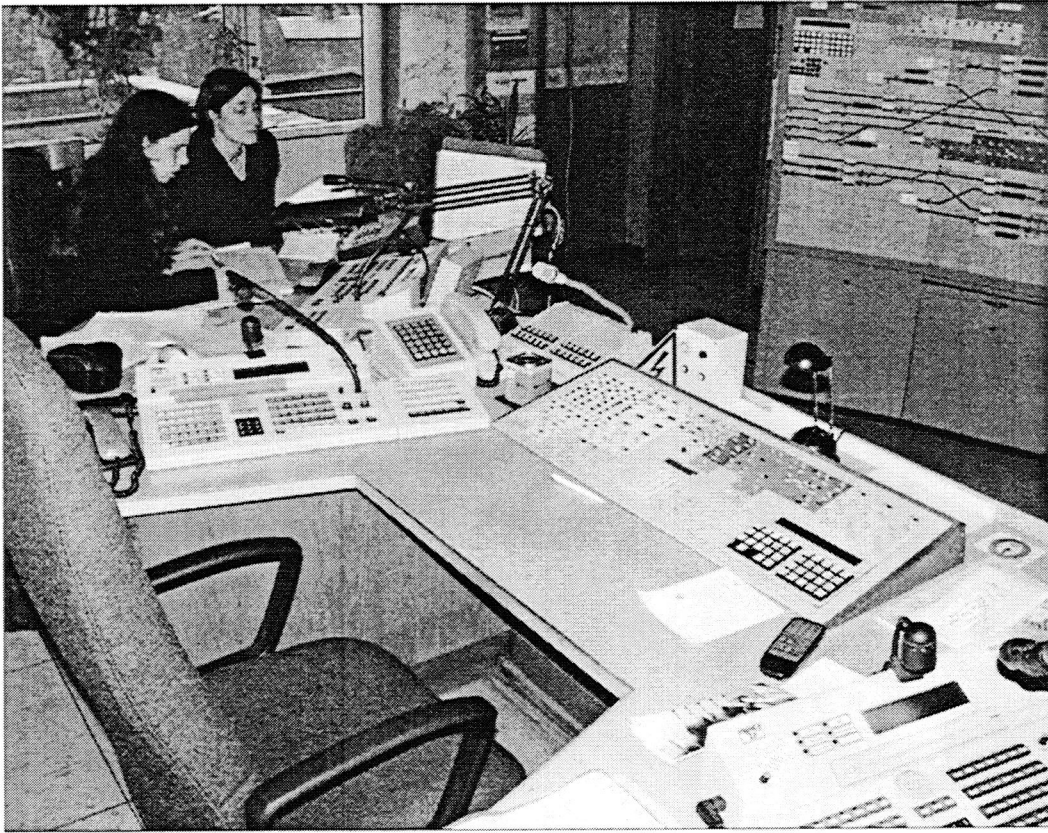
Oben der Arbeitsplatz eines Fahrdienstleiters
