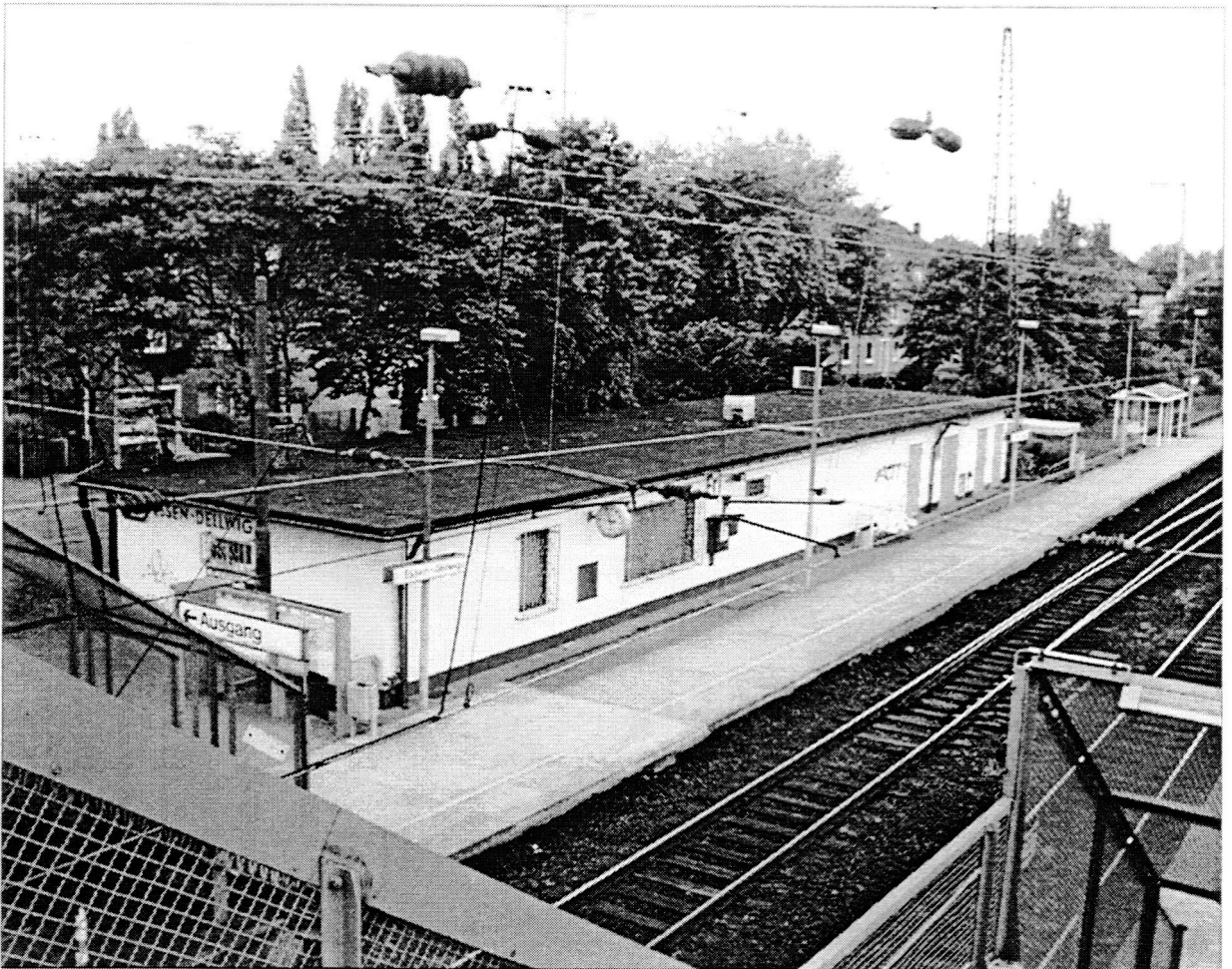
Unten Bahnsteig in Essen-Dellwig (früher Frintrop) mit Stellwerk Fri
